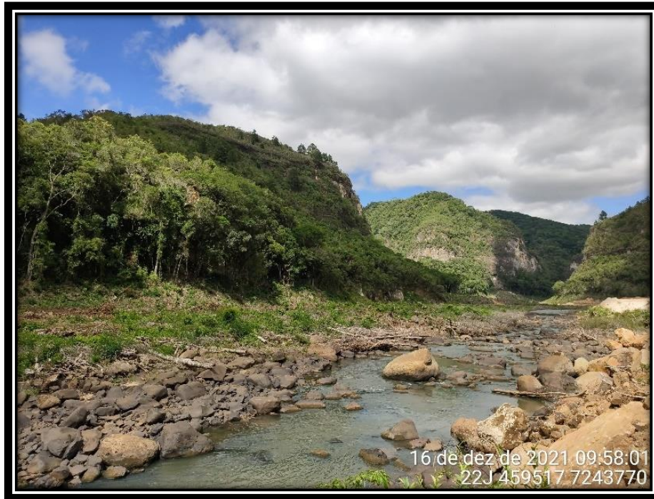
Figura 49 – Exemplo do aspecto rochoso do leito do rio Marrecas na região do futuro reservatório da PCH Confluência.
