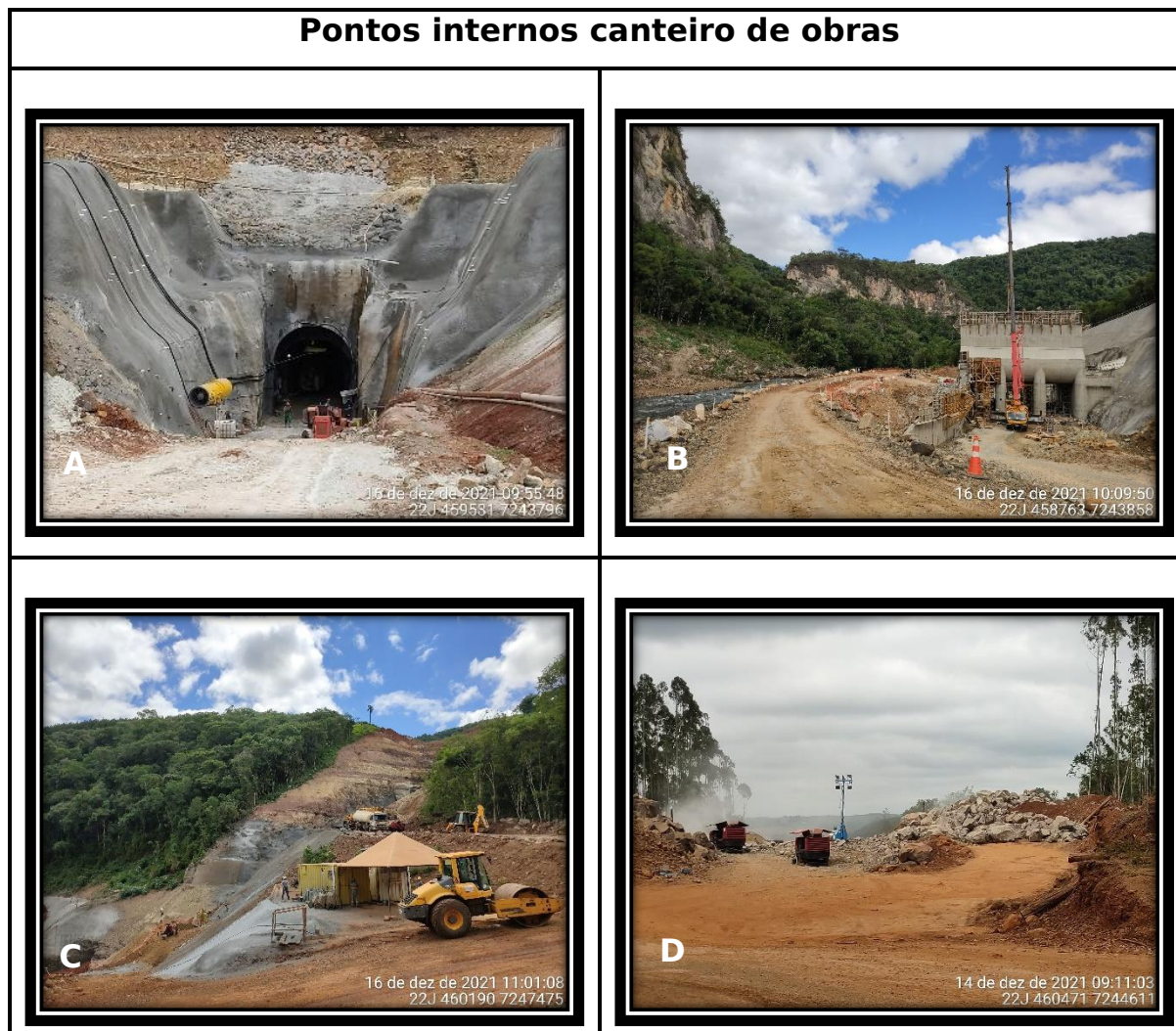
Figura 5 – Pontos do meio físico dentro do canteiro de obras.
