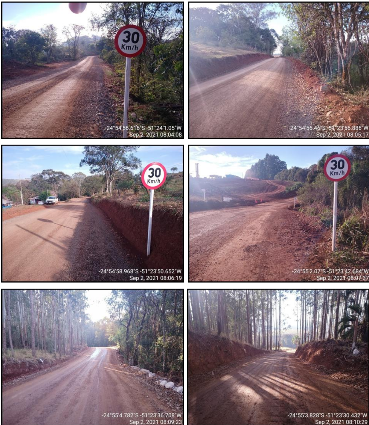
Figura 213 - Acessos externos - Trecho 04.
