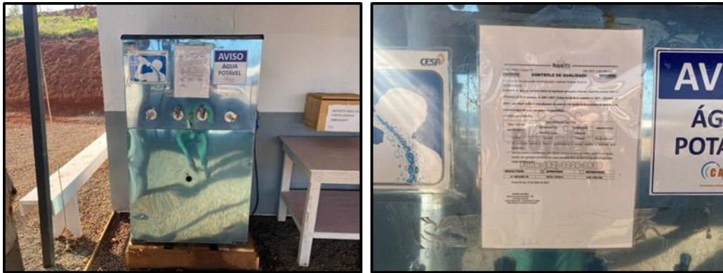
Figura 203 – Bebedouro de água devidamente lacrado com seu controle de qualidade exposto no canteiro de obras da PCH Confluência.
