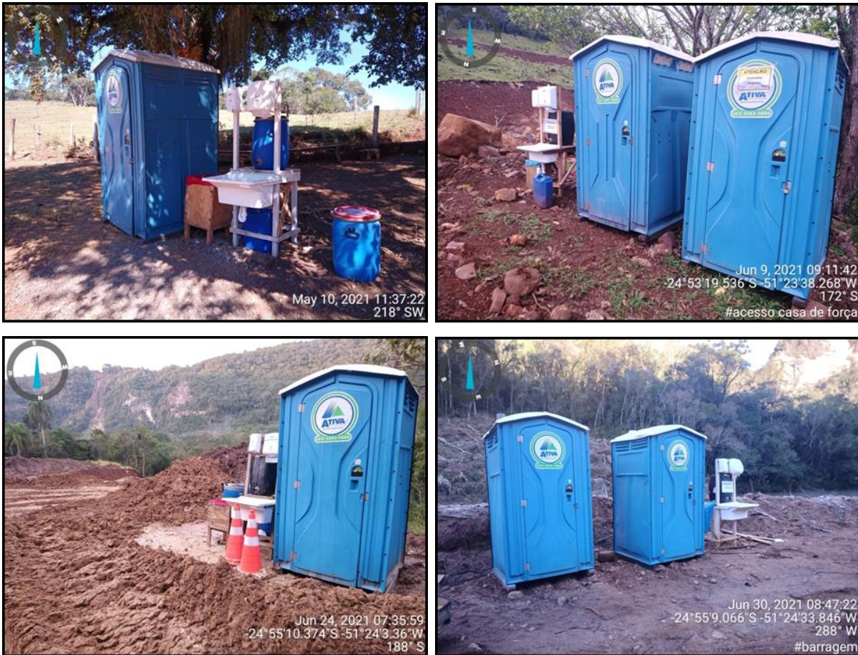
Figura 248 - Alguns banheiros químicos disponibilizados nas frentes de obras entre os meses de março e junho de 2021 na PCH Confluência.
