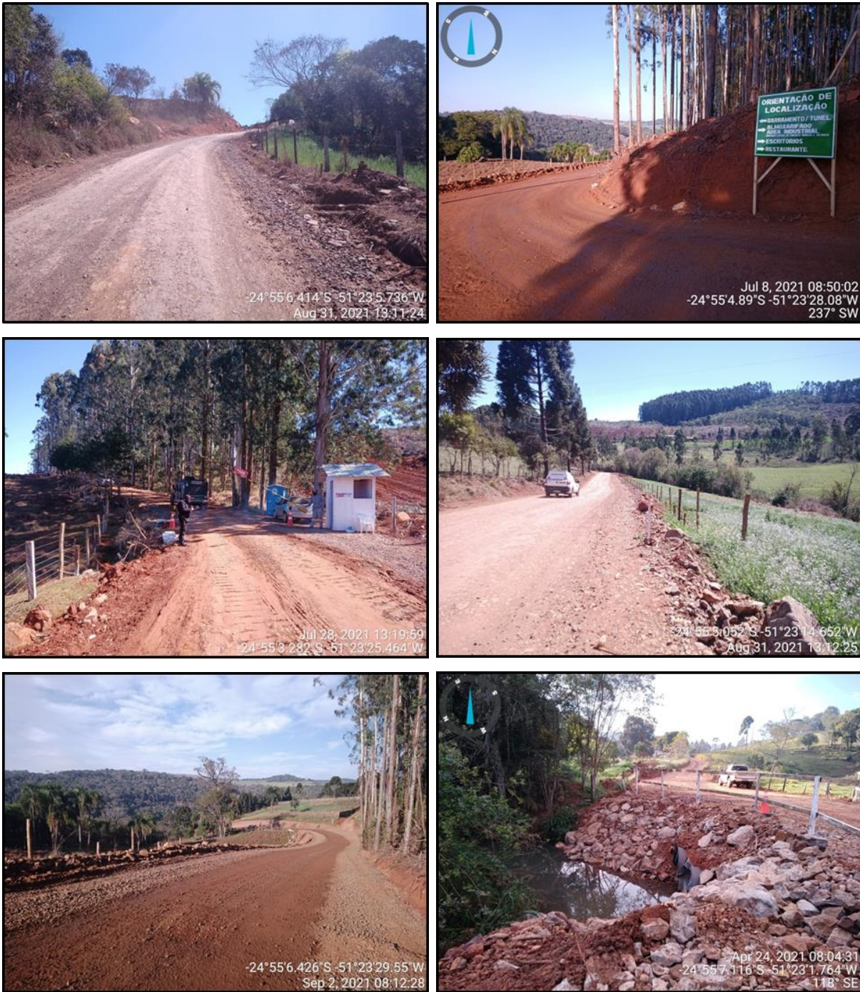
Figura 211 - Acessos externos - Trecho 02.
