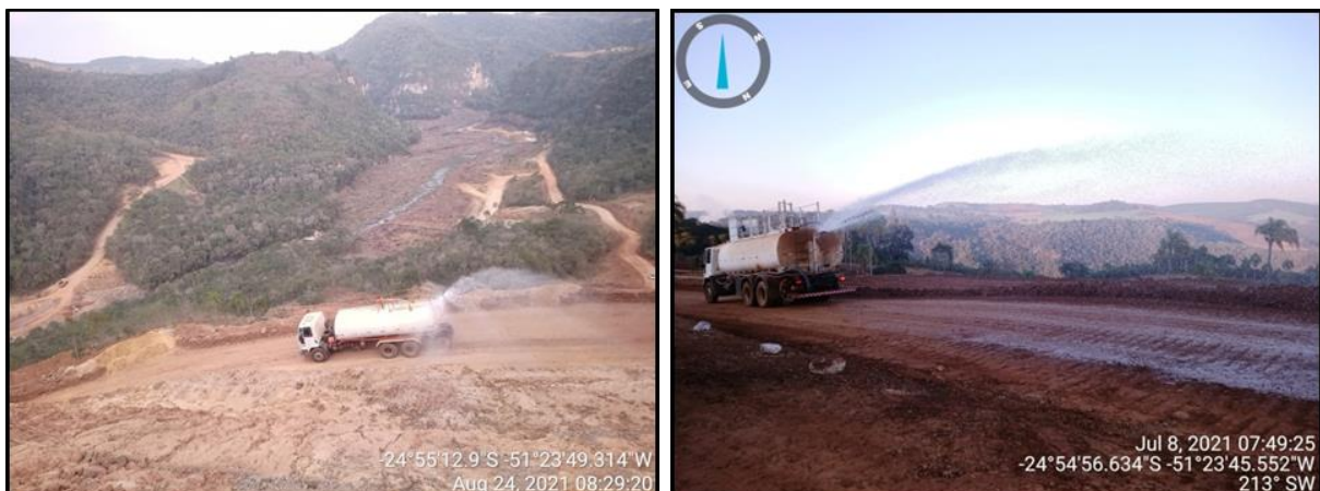
Figura 257 - Controle de material particulado em suspensão nos acessos por caminhão pipa.
