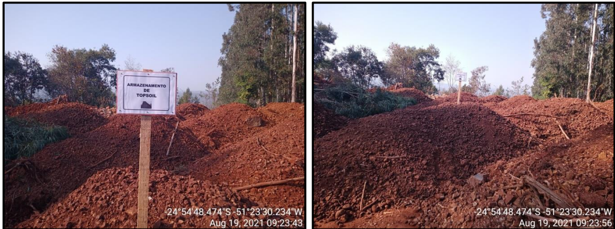
Figura 2 – Armazenando de top soil em regime de bota-espera.
