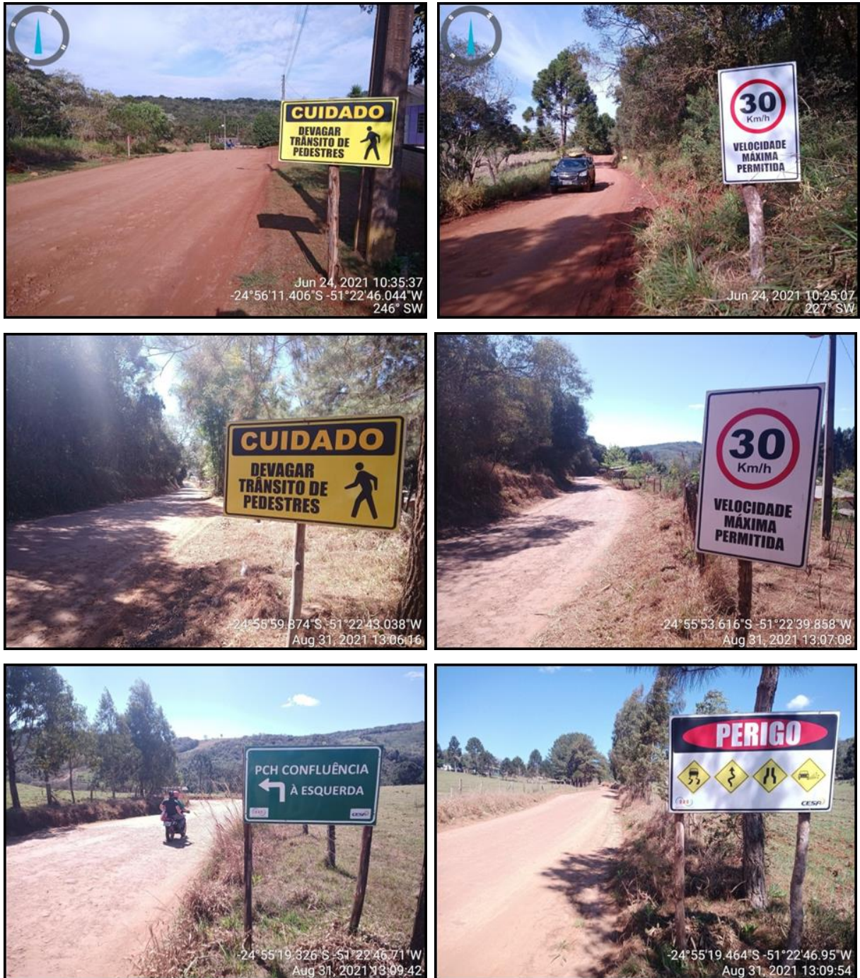
Figura 210 - Acessos externos - Trecho 01.
