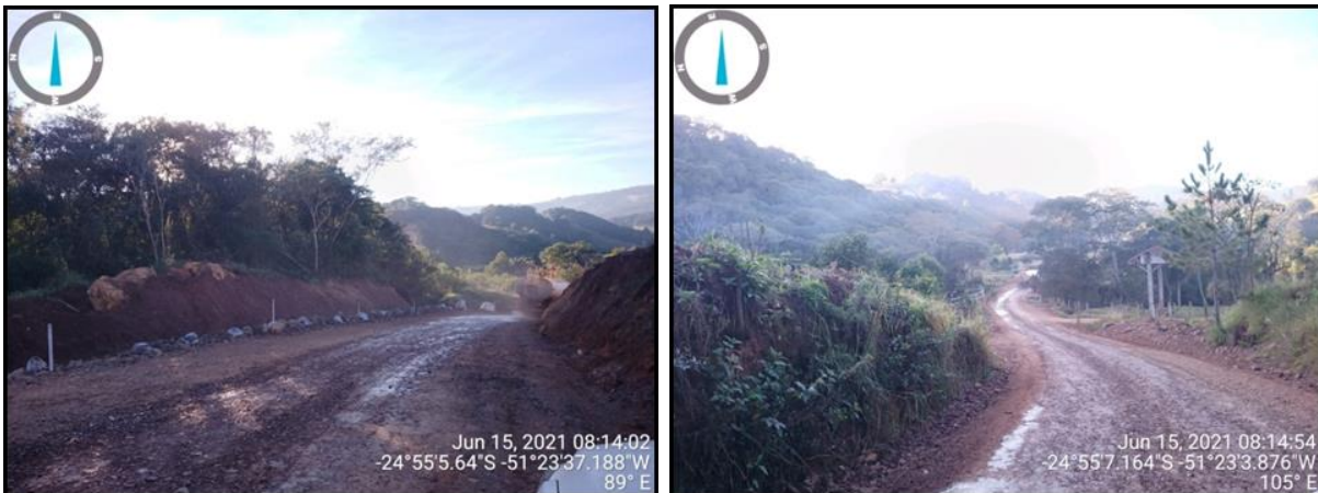
Figura 216 - Controle de material particulado em suspensão, por umectação, nos acessos externos da PCH Confluência.
