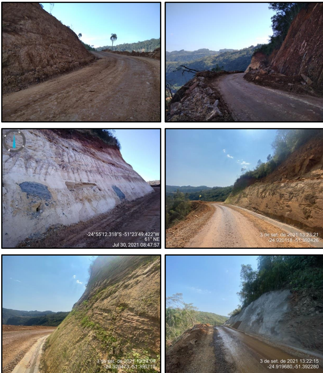
Figura 14 – Via de acesso ao barramento e a tomada de água baixa, logo após sua implantação, em junho e julho (A, B e C) e após a execução de medidas
