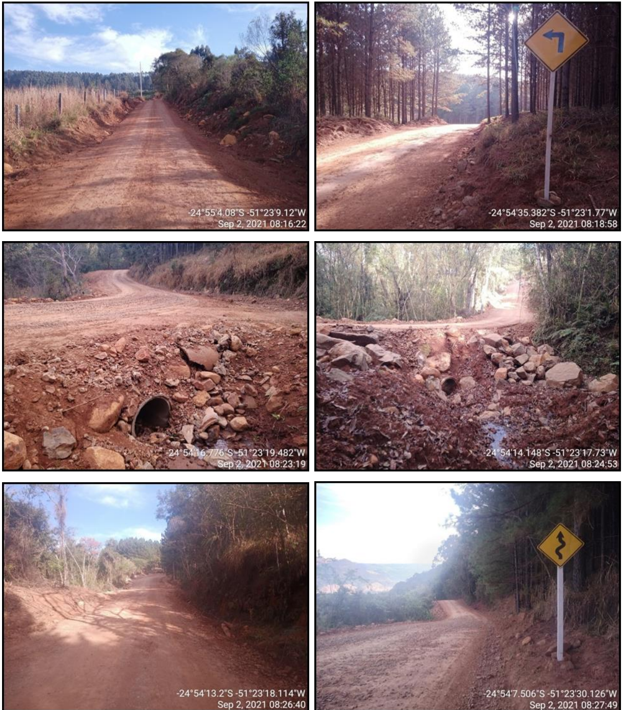
Figura 212 - Acessos externos - Trecho 03.
