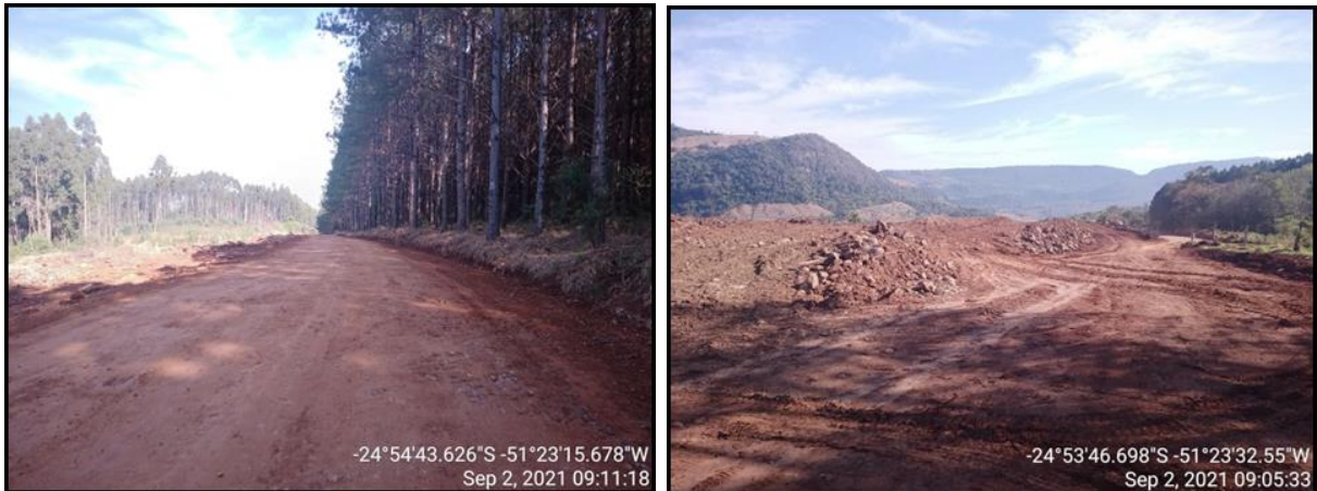
Figura 214 - Acessos externos - Trecho 05.
