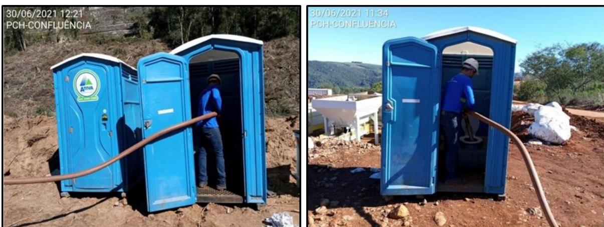
Figura 249 - Limpeza dos banheiros químicos sucção de caminhão tanque.
