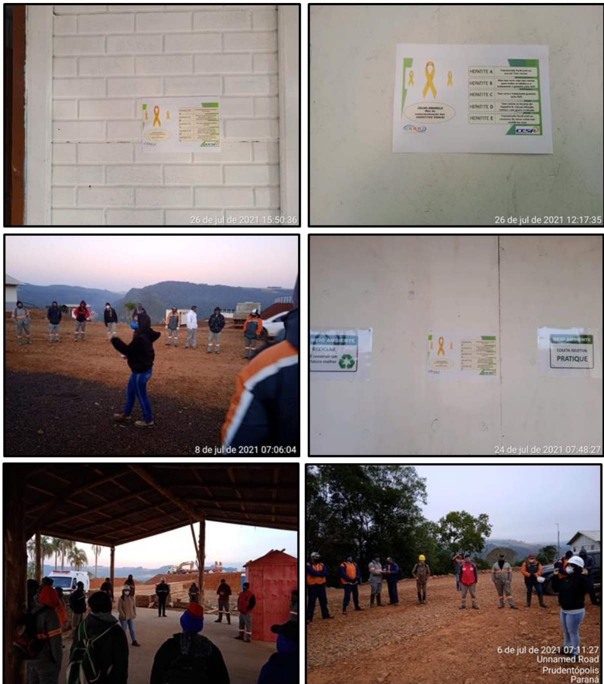
Figura 201 – Cartazes informativos e diálogos diários de segurança acerca das Hepatites Virais no canteiro de obras da PCH Confluência.
