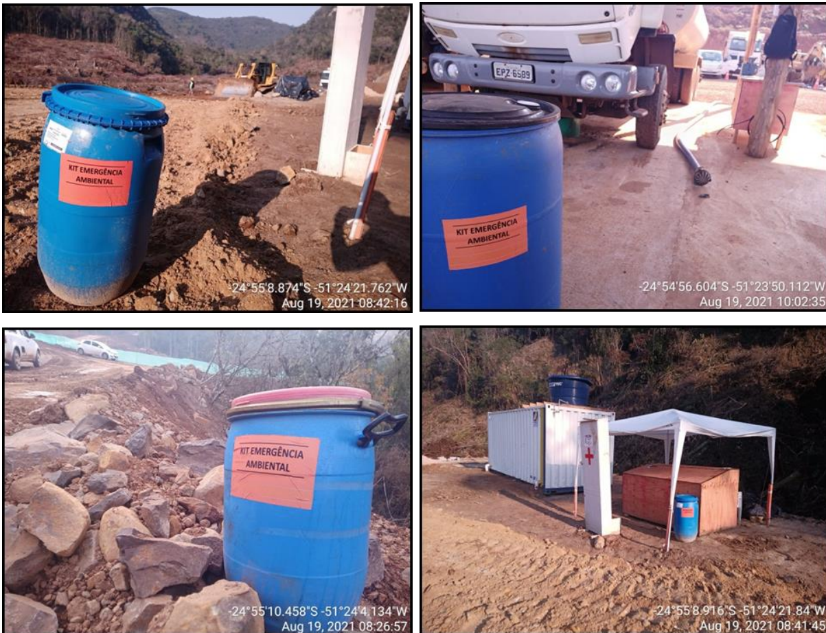
Figura 244 - Exemplos de kit de mitigação disponibilizados nas frentes de serviço e no canteiro da PCH Confluência. Em geral, os kits contem serragem, pá antifáisca, luva nitrílica e bacia de contenção.
