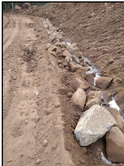
Figura 16 – Implantação de blocos e matacões em drenagem provisória.
