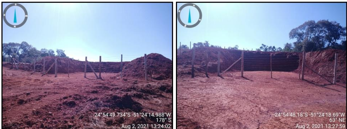
Figura 245 - Paio de explosivos com separação entre local de armazenamento de explosivos e de acessórios da PCH Confluência.
