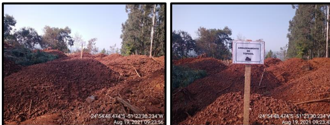
Figura 168 – Topsoil armazenado no canteiro industrial da PCH Confluência.
