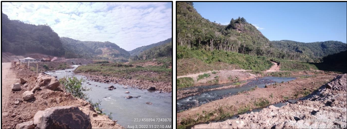
Figura 33 - Áreas do futuro reservatório suprimidas durante a implantação da PCH Confluência.
