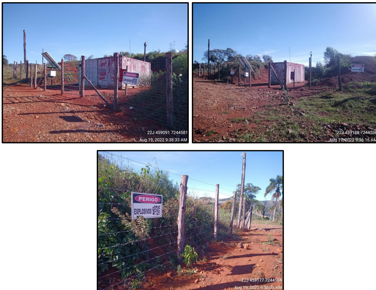
Figura 168 - Paiol de explosivos com separação entre local de armazenamento de explosivos e de acessórios da PCH Confluência.
