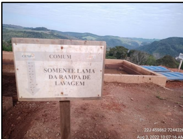
Figura 171 – Rampa de lavagem e sistema de tratamento de efluentes da oficina composto por sistema de drenagem, decantador, caixa SAO e sumidouro; e exemplo de limpeza periódica.
