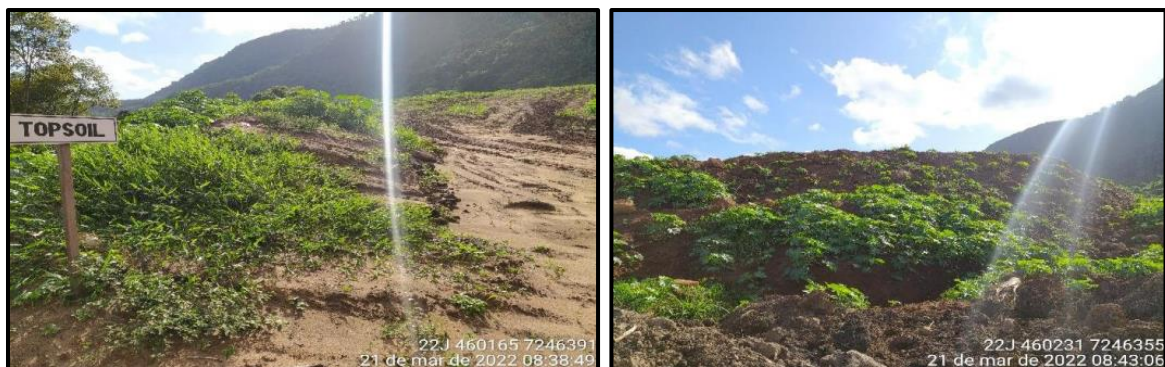
Figura 3 – Armazenamento de topsoil em regime de bota-espera.
