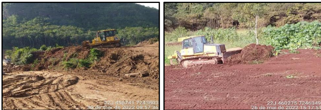
Figura 2 – Decapagem e transporte de topsoil .
