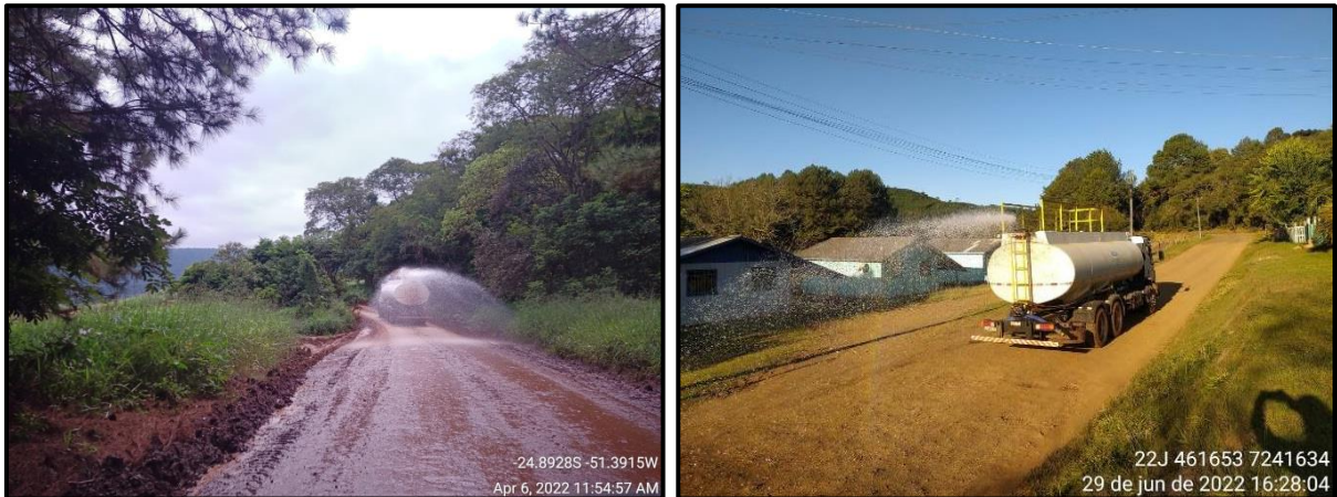
Figura 140 - Controle de material particulado em suspensão, por umectação, nos acessos externos da PCH Confluência.
