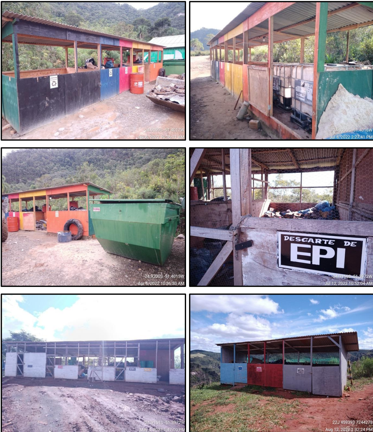
Figura 153 – Centrais de resíduos classe II (03 unidades) no canteiro de obras da PCH Confluência. Três unidades.
