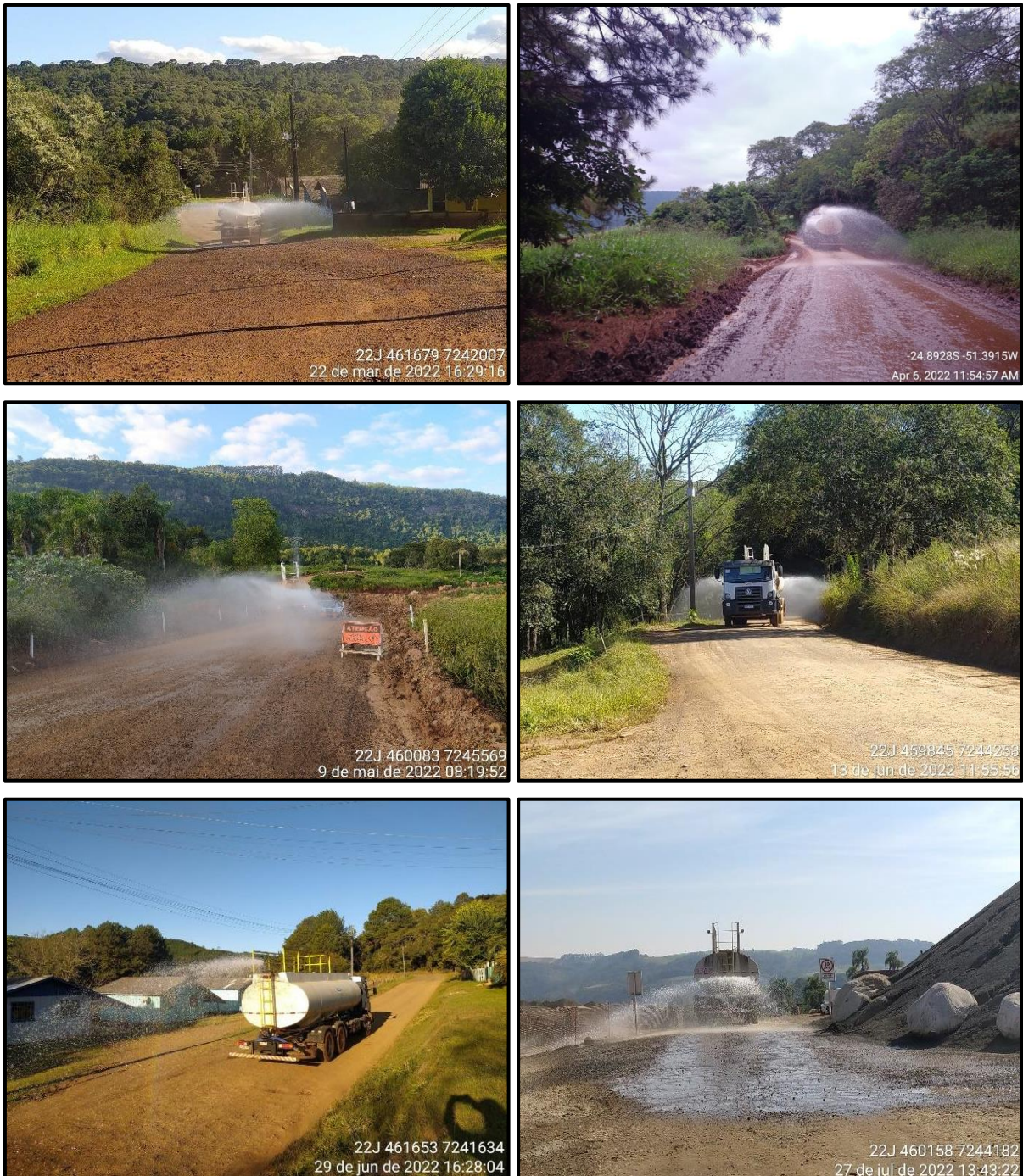
Figura 181 - Controle de material particulado em suspensão nos acessos internos e externos por caminhão pipa.
