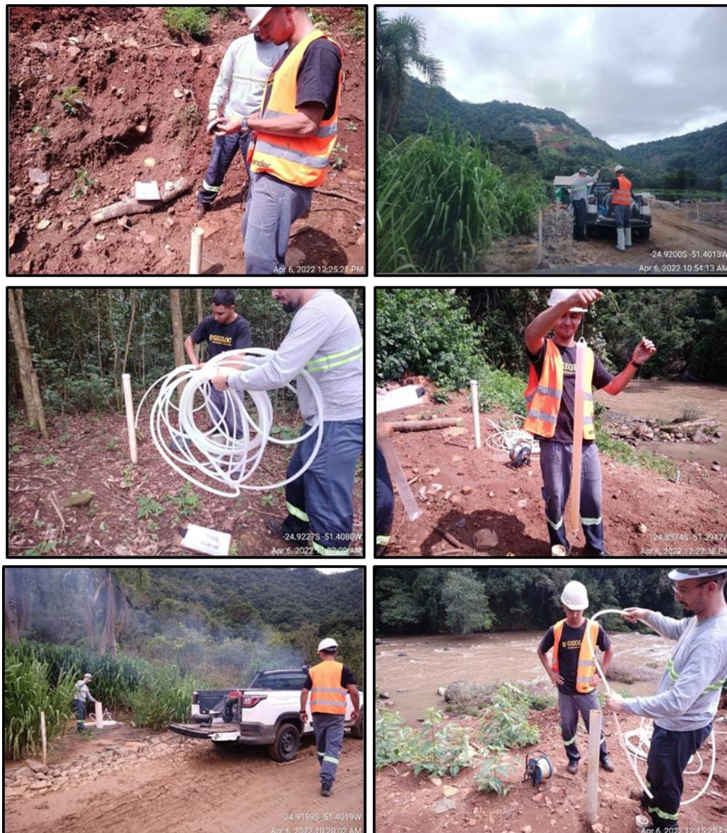
Figura 22 – Vistoria da empresa terceirizada para aferição de coluna d’água e profundidade nos PMs e MNAs instalados.
