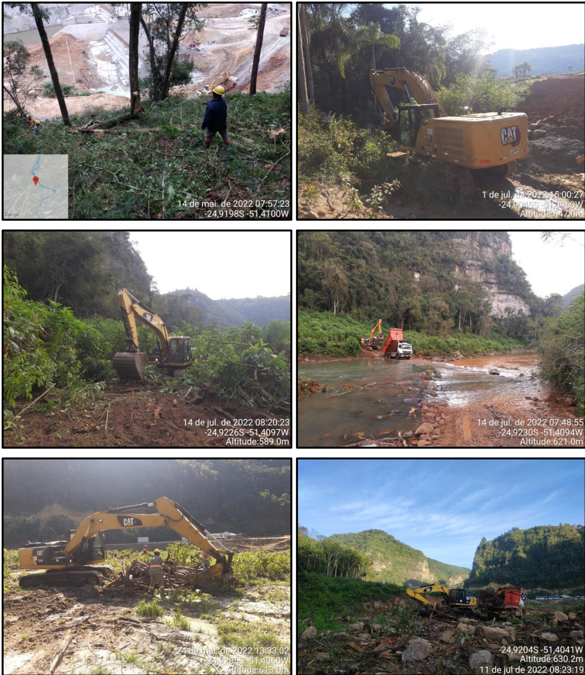
Figura 32 - Atividade de remoção do material vegetal oriundo da supressão do reservatório na confluência entre os rios Marrecas e Cachoeira, com o acompanhamento da equipe de resgate de fauna.
