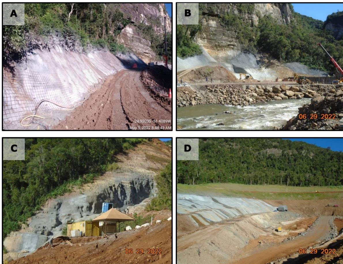
Figura 15 – Contenção de taludes com concreto projetado, realizada no primeiro semestre de 2022.
