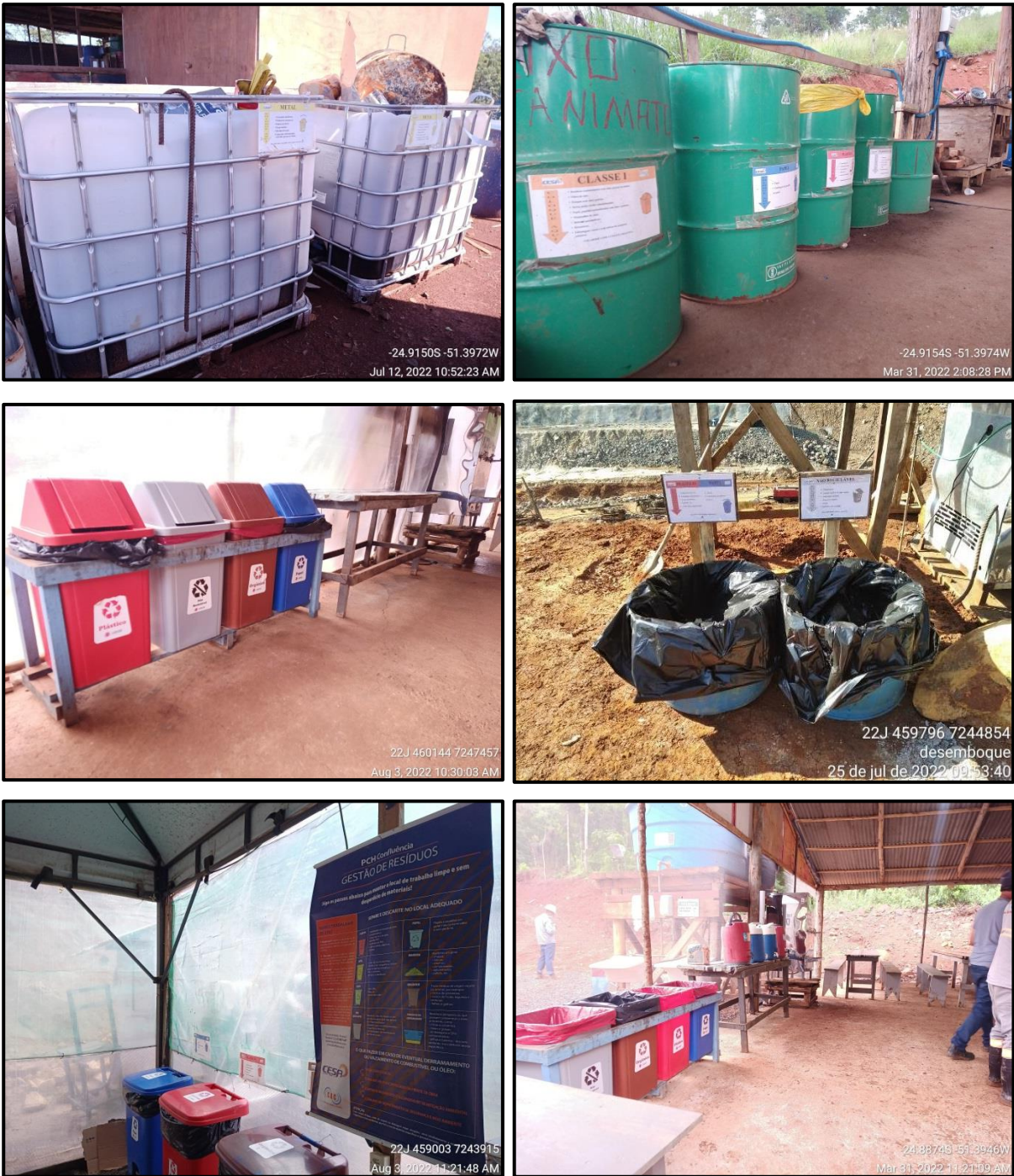
Figura 155 - Exemplos de coletores seletivos nos refeitórios e frentes de serviço do canteiro da PCH Confluência.
