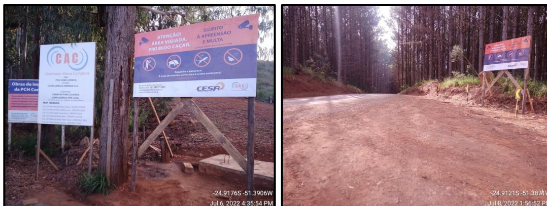
Figura 75 - Placas instaladas no canteiro de obras.
