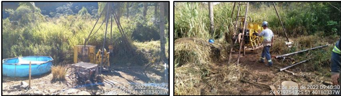
Figura 23 – Manutenções realizadas nos poços no início de agosto de 2022.
