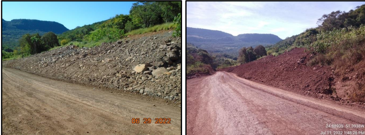
Figura 17 – Medidas mitigadoras no talude da via de acesso à casa de força, realizadas no primeiro semestre de 2022.
