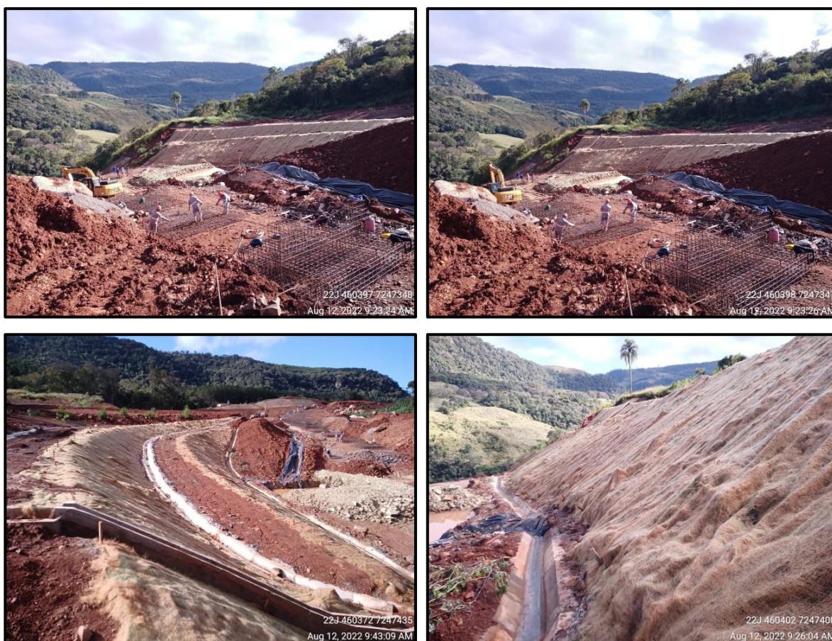
Figura 5 – Recuperação de taludes expostos na tomada d'água de alta pressão.
