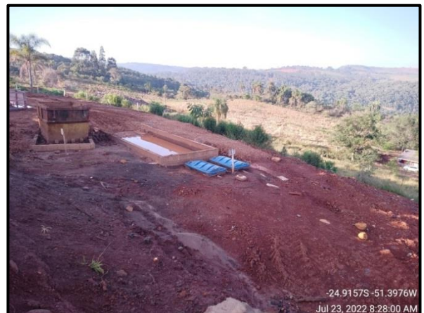
Figura 171 – Rampa de lavagem e sistema de tratamento de efluentes da oficina composto por sistema de drenagem, decantador, caixa SAO e sumidouro; e exemplo de limpeza periódica.
